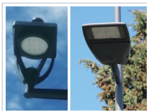
Figure 11 : Luminaires équipés de LED.
