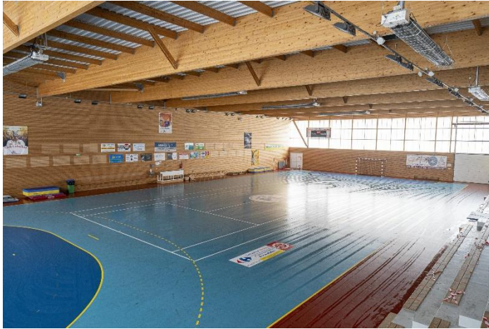
© Eiffage Énergie Systèmes
