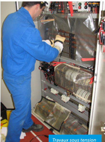
Travaux sous tension en milieu industriel
